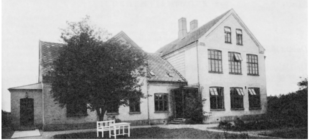
Bygningen som i dag rummer bibliotek, arkiv og kontor for dagplejeadministrationen. Billedet er fra 1920'erne, hvor der var have foran bygningen ud mod Dalumvej.
