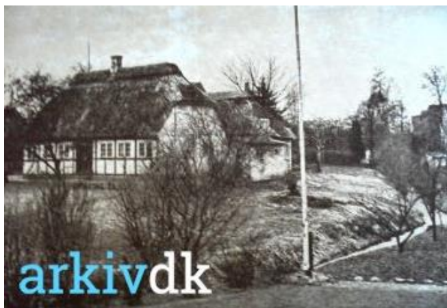
Tinglækkehuset (Dalumvej 25) ved siden af Sorgenfribækken
