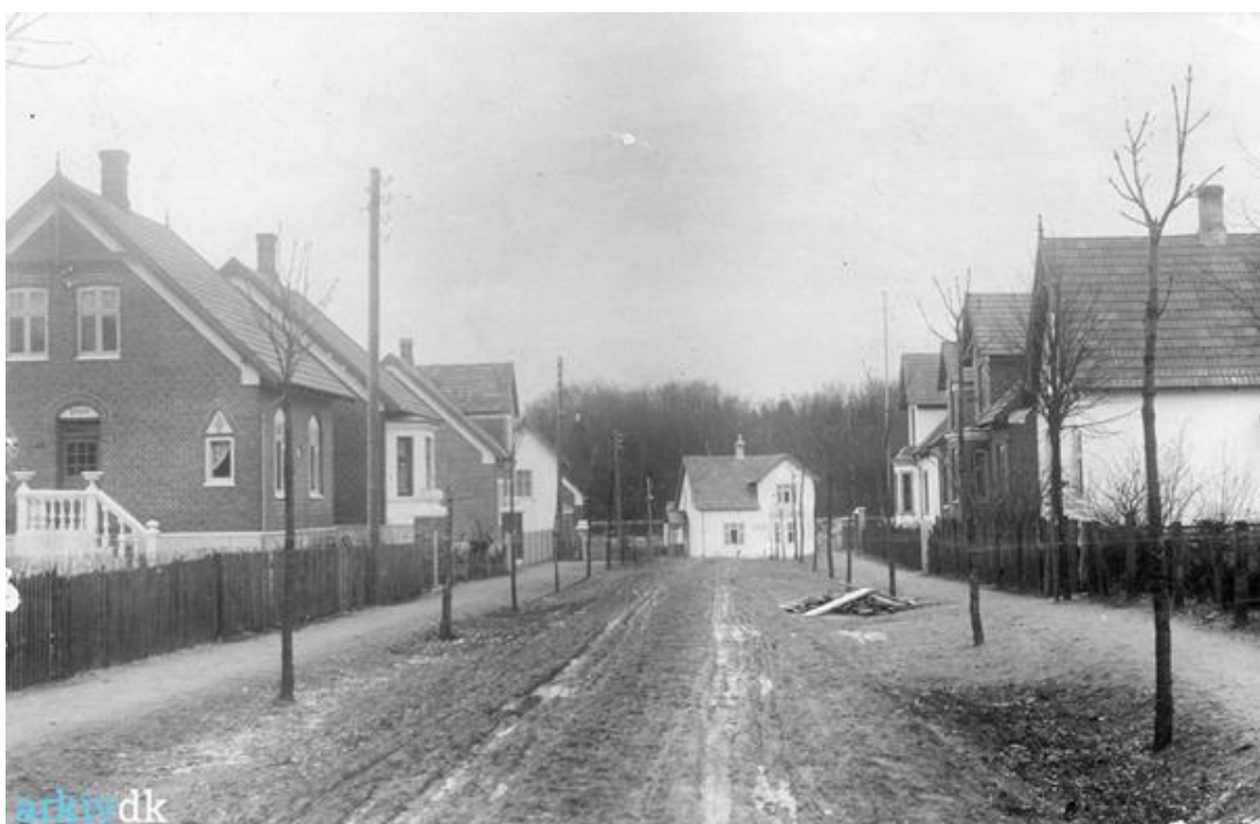
Lykkeshåbs allé med Lindevej i baggrunden cirka 1925
