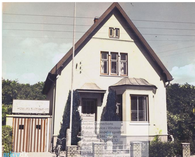
Lindevej 8 i 1952. Mange huse på Lindevej fik tilbygget garage i takt med, at beboerne fik bil.
