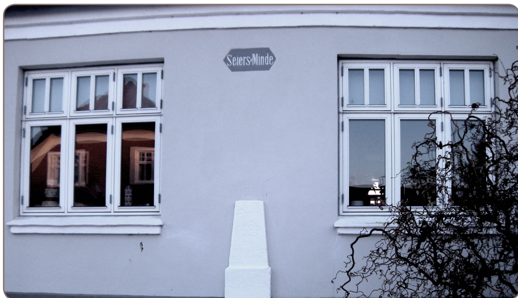
Seiers-Minde på Lykkeshåbs Alle 7. Facaden er nymalet, og det er derfor svært at se indskriften på den hvide udmuring midt i billedet. Der er indhugget: F VIII 1909 og nedenunder GUD velsigne Danmark. Umiddelbart over udmuringen er der indhugget en kongekrone i muren. (Jytte Raun, Dalum-Hjallese Lokalhistoriske Arkiv)
