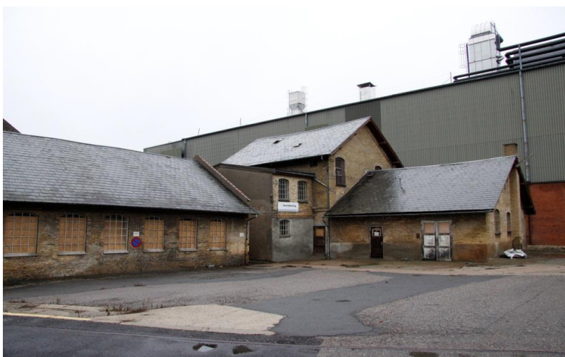
Bygningerne fra sidste halvdel af 1900 tallet er opført i røde sten og beton med fladt tag og 4-5 etager
