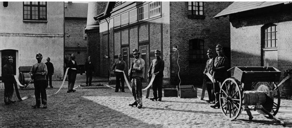
Opstilling til brandøvelse på papirfabrikken i 1911
