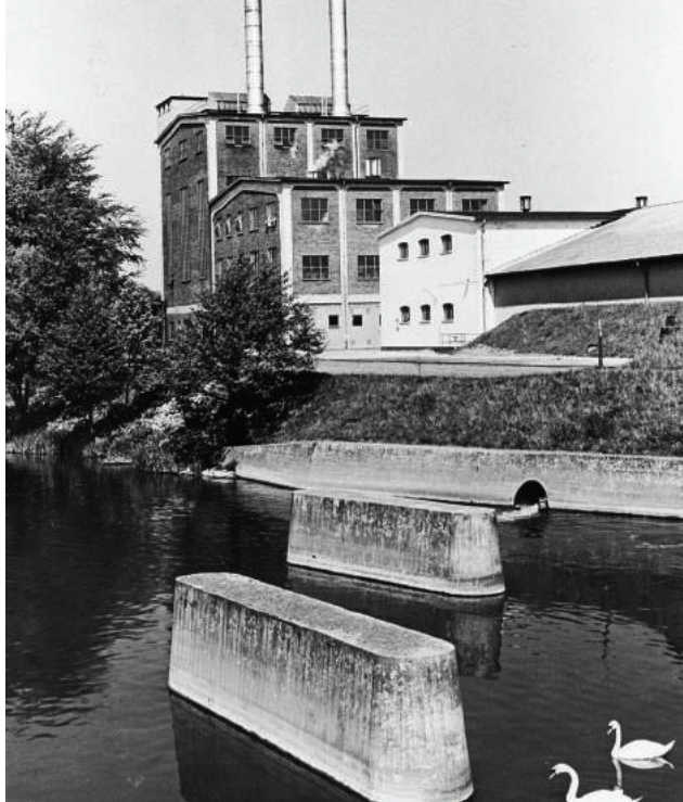
Kraftcentralen. Betonpillerne i åen var beregnet til at bære et sæt nye jernbanespor, som dog aldrig blev til noget
