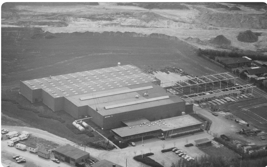
Fabriksanlægget på Industrivej 9. Virksomheden nederst i venstre hjørne er Specialbeton. På billedet ses det tydeligt, hvor tæt på industrigrunden husene på Julagervænget kom til at ligge. Billedet er taget i begyndelsen af 1980'erne, hvor man i baggrunden kan se udgravningen til motorvejsudvielsen, som blev indviet i 1985. Foto: Maskinfabrikken ACTA
