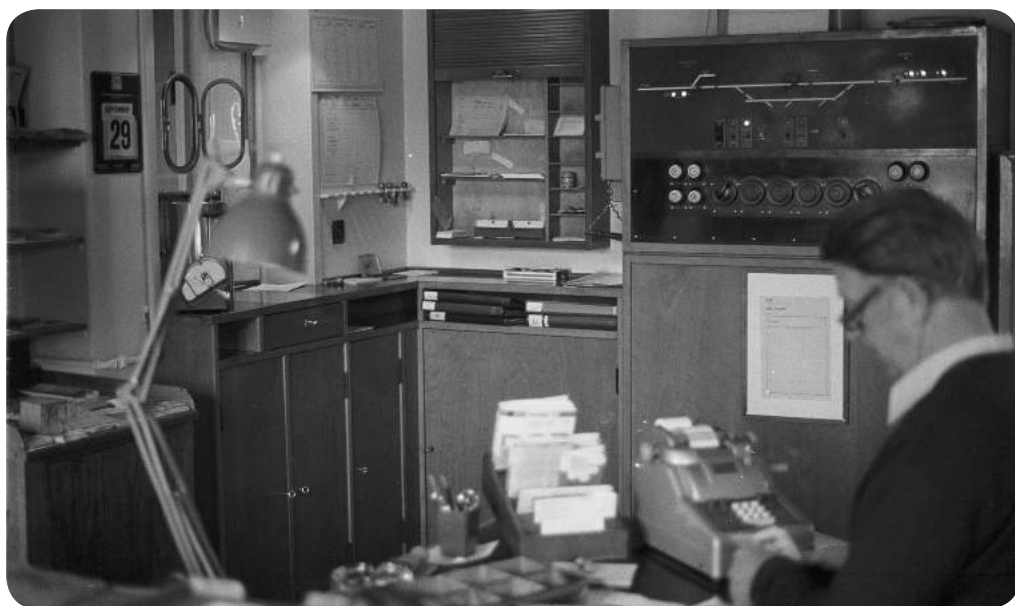
Til venstre ses billetsalget. Til højre ses stationens centralapparat for relæsikringsanlægget. Foto: Dalum-Hjallesø Lokalarkiv.
