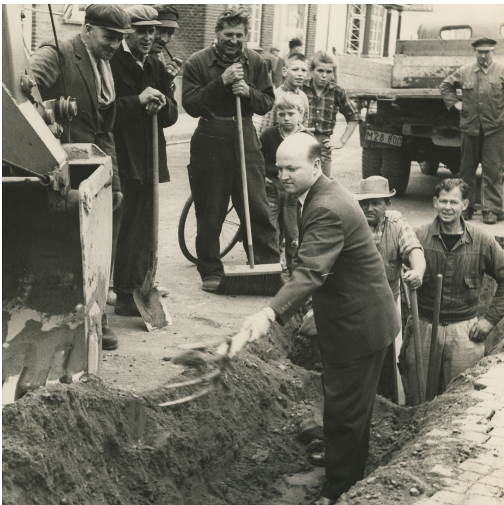
Fjernvarmerør bliver gravet ned i Dalum 1960-61. Formanden for teknisk udvalg Dalum sogneråd, forretningsfører Svend Johansen, tager det første spadestik.
